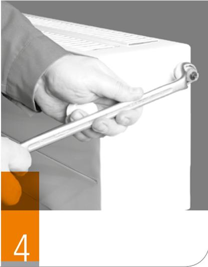
Ziehen Sie den neuen Ventileinsatz mit einem Anzugsmoment von 35 bis 40 Nm\* fest.
